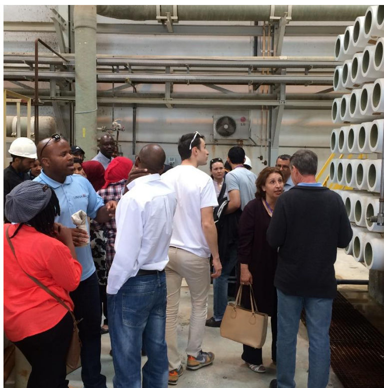
Visite de la station d'Osiose Inverse (Groupe Chimique Tunisien ) de dessalement de mer de Skhira, e, banlieue de Sfax, Tunisia
